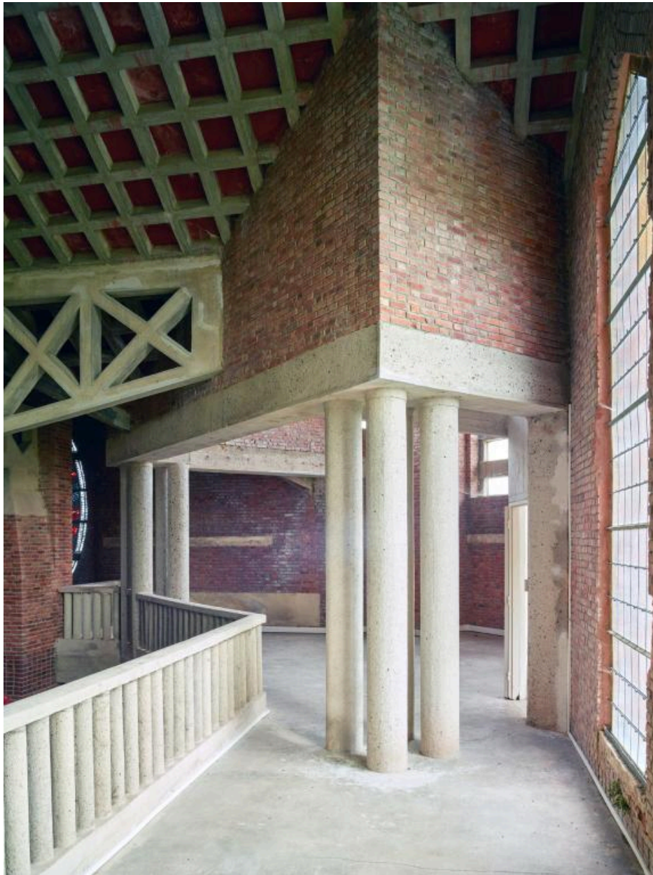
Élément de charpente depuis la tribune.
