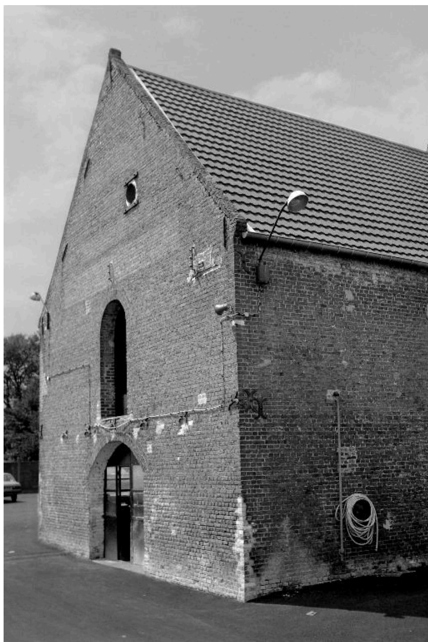
Atelier de fabrication, flanc est.
