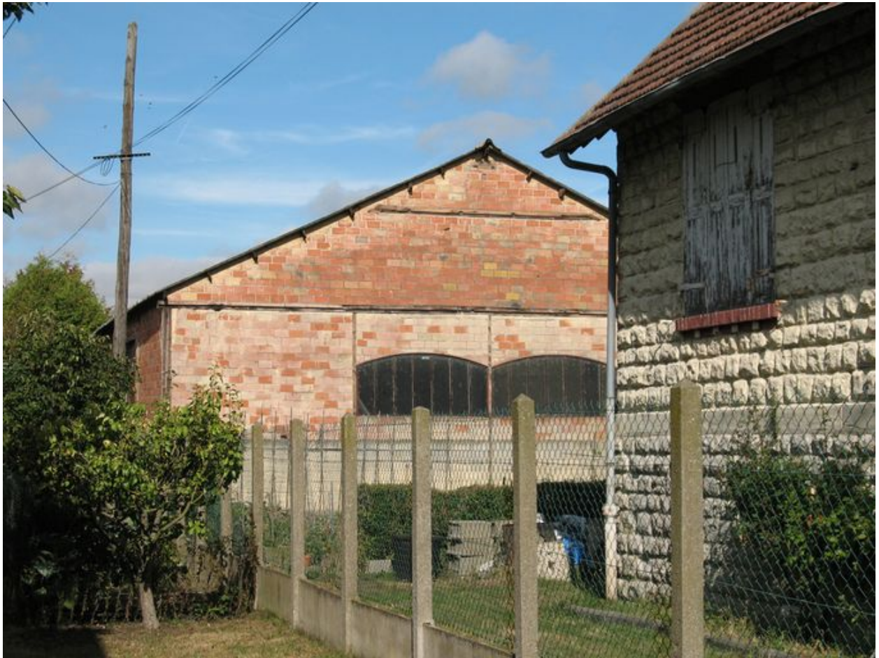
Mur pignon sud du magasin de stockage des fûts.
