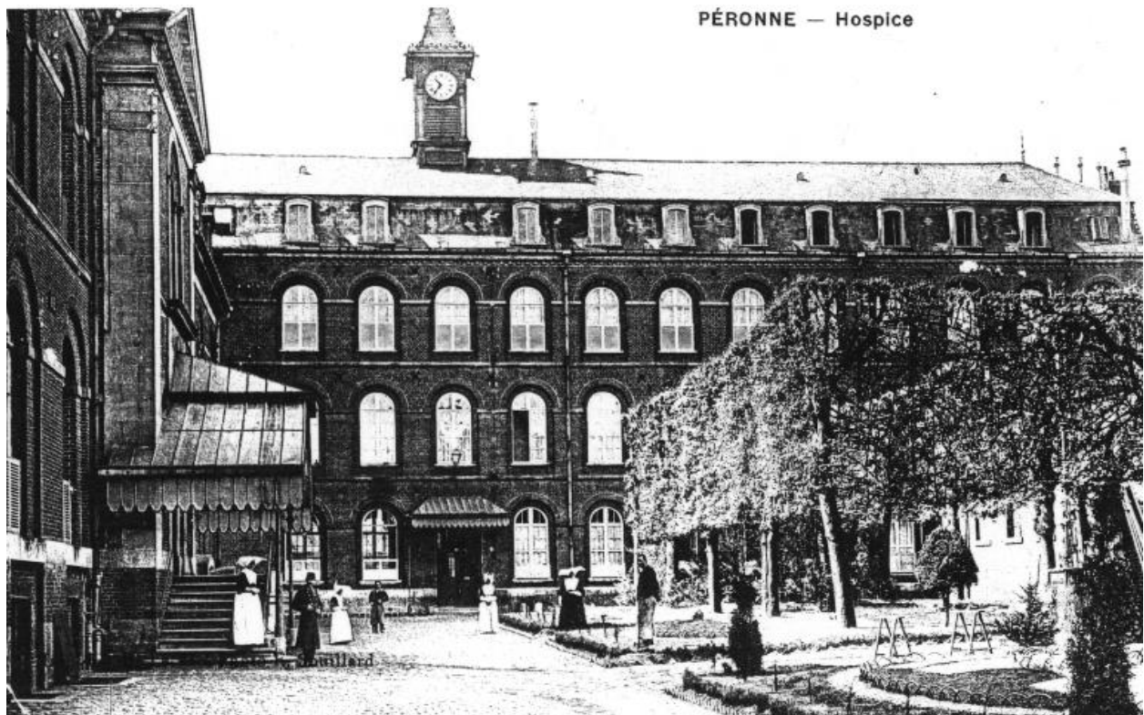
L'Hospice de Péronne. Le bâtiment des malades à gauche et le bâtiment des religieuses, avant 1914, carte postale (Musée Danicourt, Péronne).
