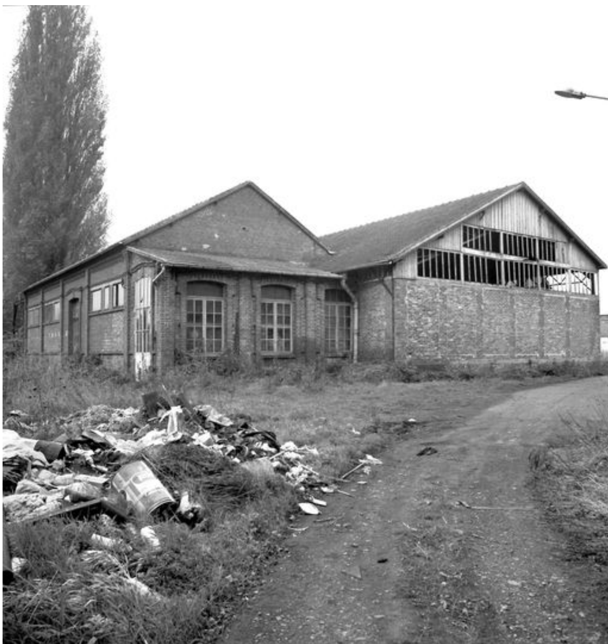
Magasin des pièces détachées et hangar, dit bâtiment H 13, façade nord.
