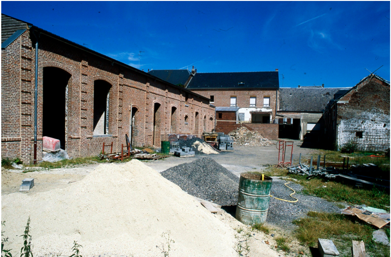
Vue générale de l'aile occidentale de l'ancienne brasserie-malterie, depuis la cour, en cours de restauration (août 2001).
