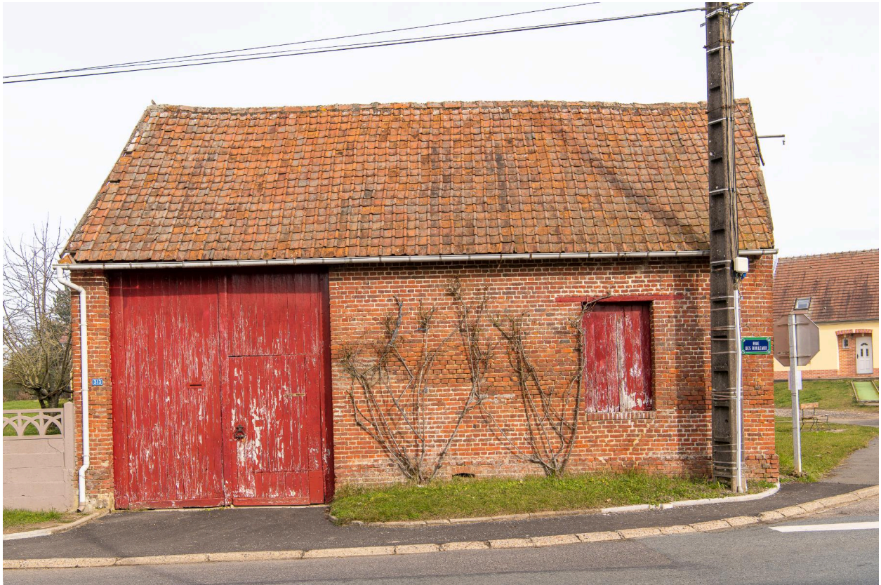
Grange sur rue avec entrée charretière, n°313 rue des Bouleaux, vue depuis le sud.
