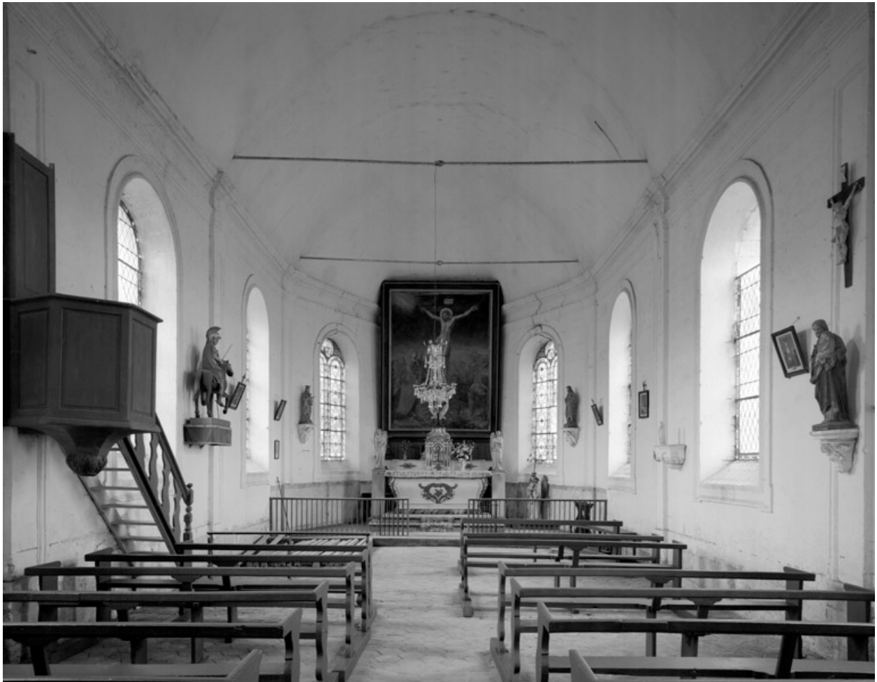
Vue intérieure, vers le chœur.
