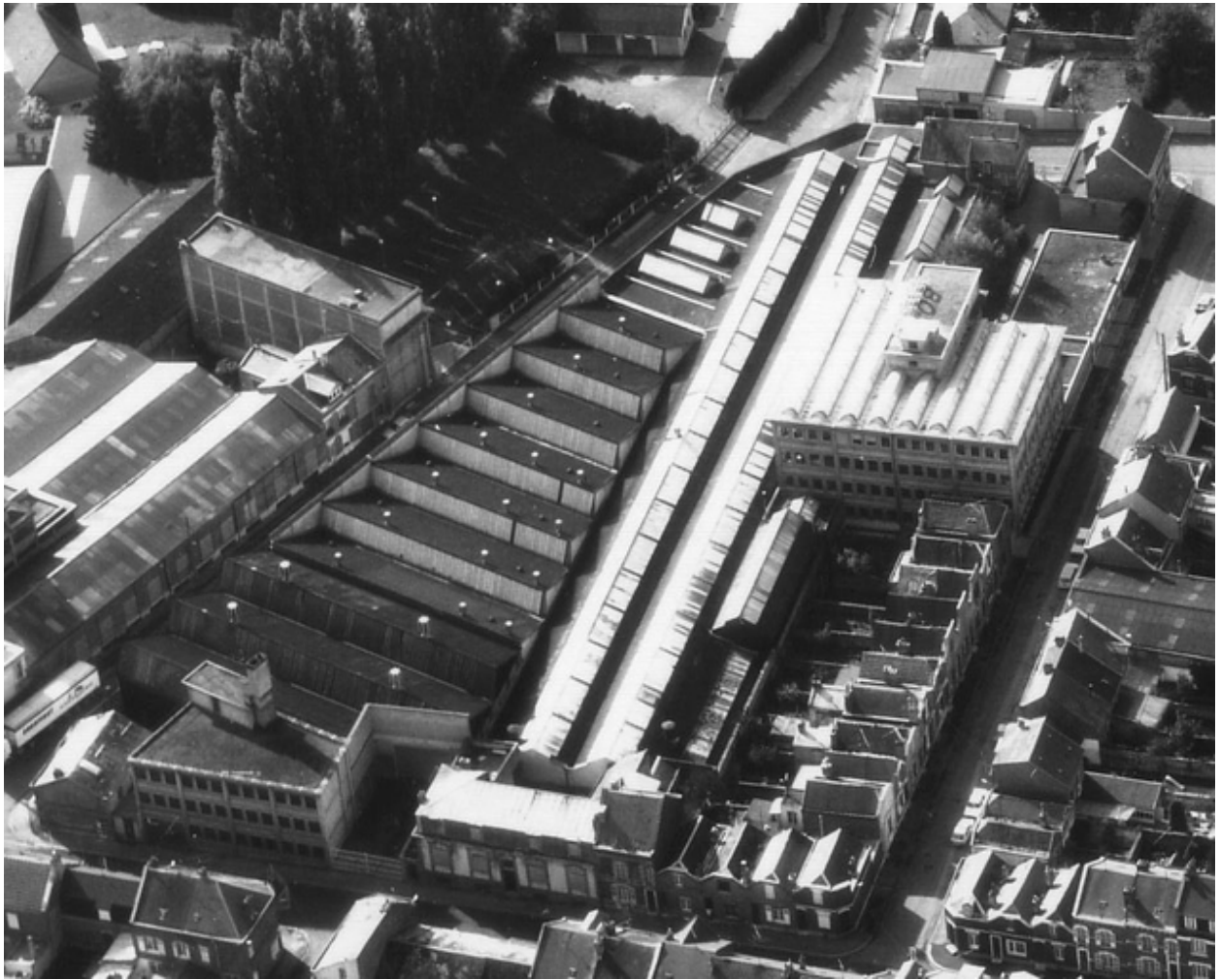
Les Etablissements Boyer vus de l'est en 1989.
