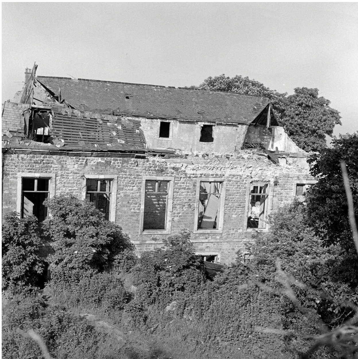
Bâtiment F, façade nord-est sur rempart, vers nord, au deuxième plan, bâtiment E.
