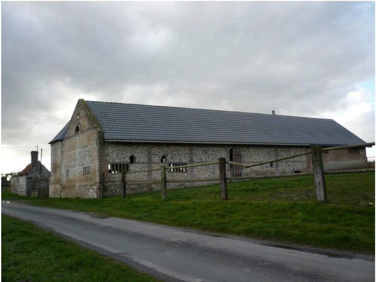
Vue postérieure des dépendances.
