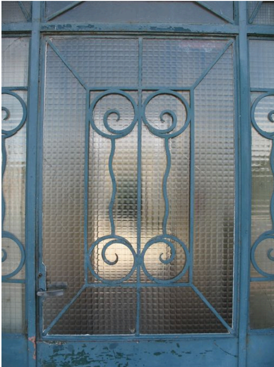
Bâtiment 520 : Détail de la porte d'entrée.
