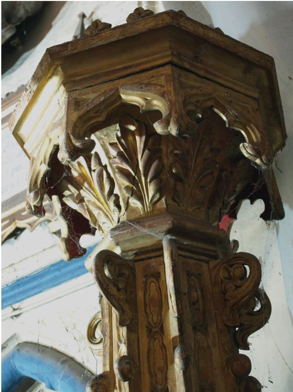
Vue de détail, partie supérieure
