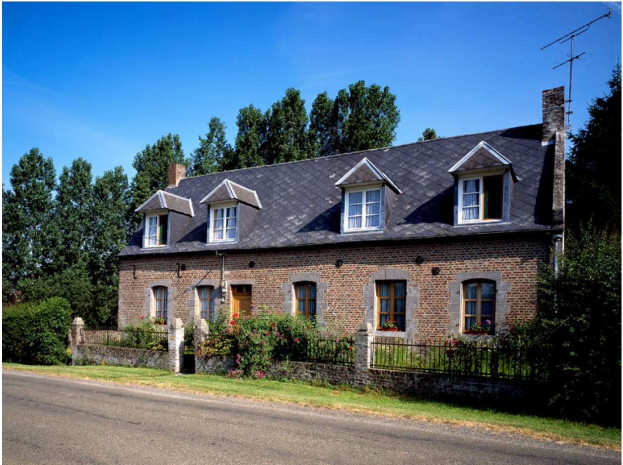
Façade du logis.
