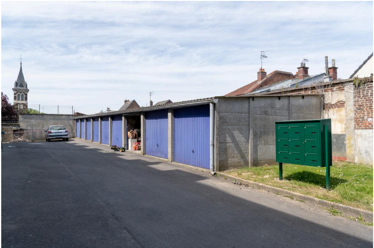
Arrière de la cour : les garages.
