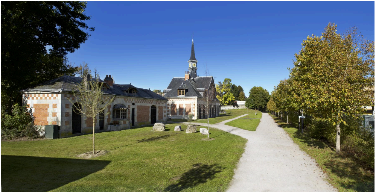
Vue d'ensemble depuis l'ancienne voie ferrée transformée en voie verte.
