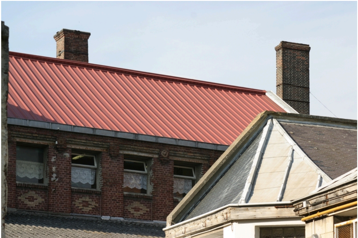
Magasin à farine (façade sur cour).
