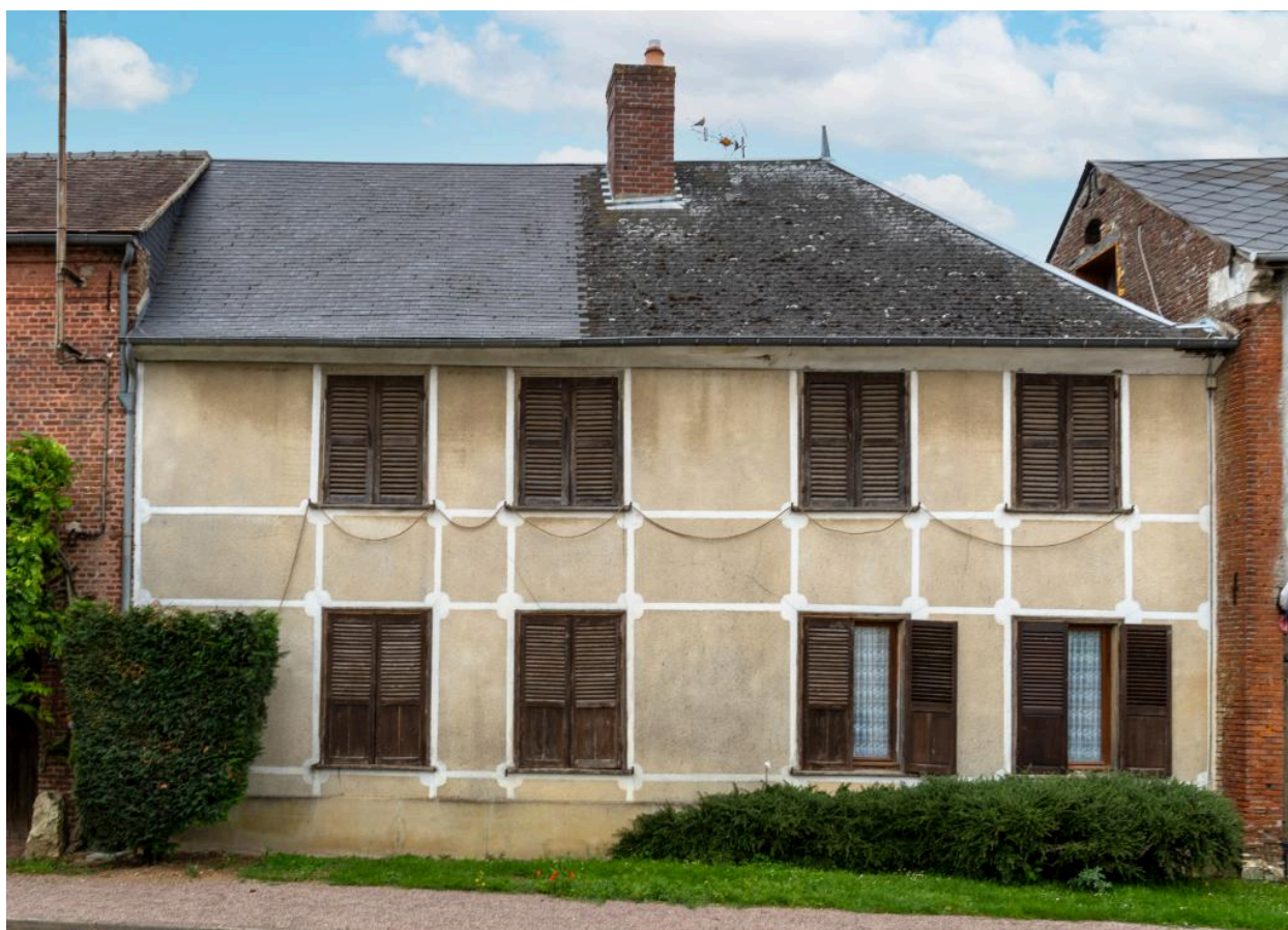
Logis sur rue, n°24 rue Principale, vue depuis l'est.
