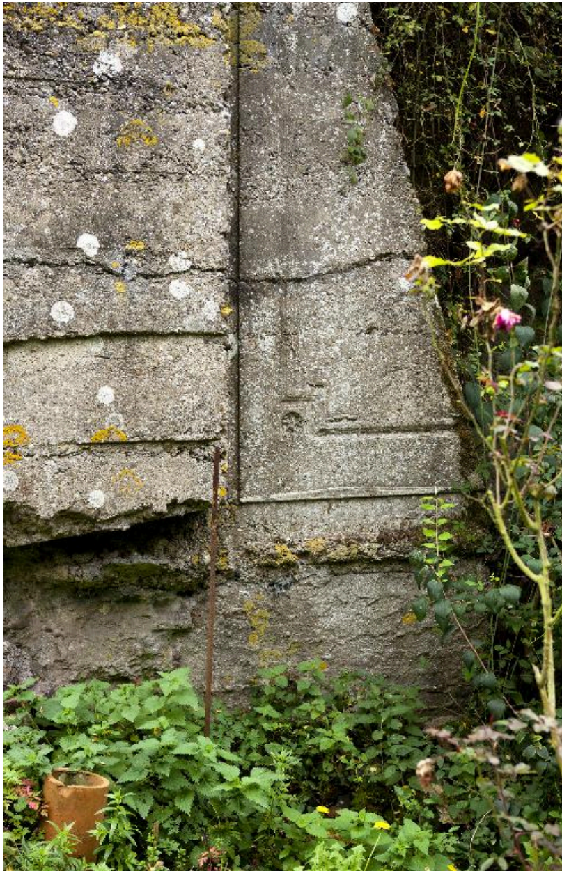
Détail du contrefort est. Empreintes d'une porte
