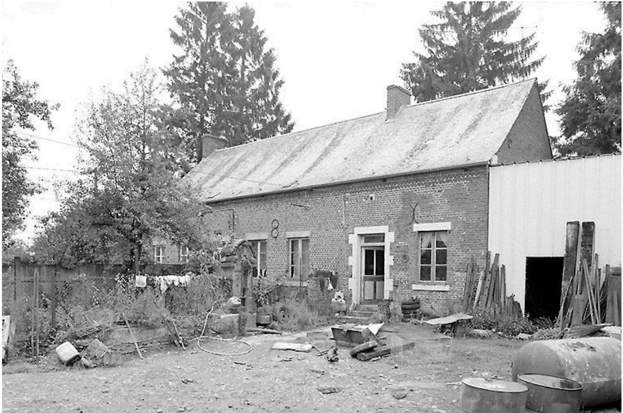
Vue du logis en brique.
