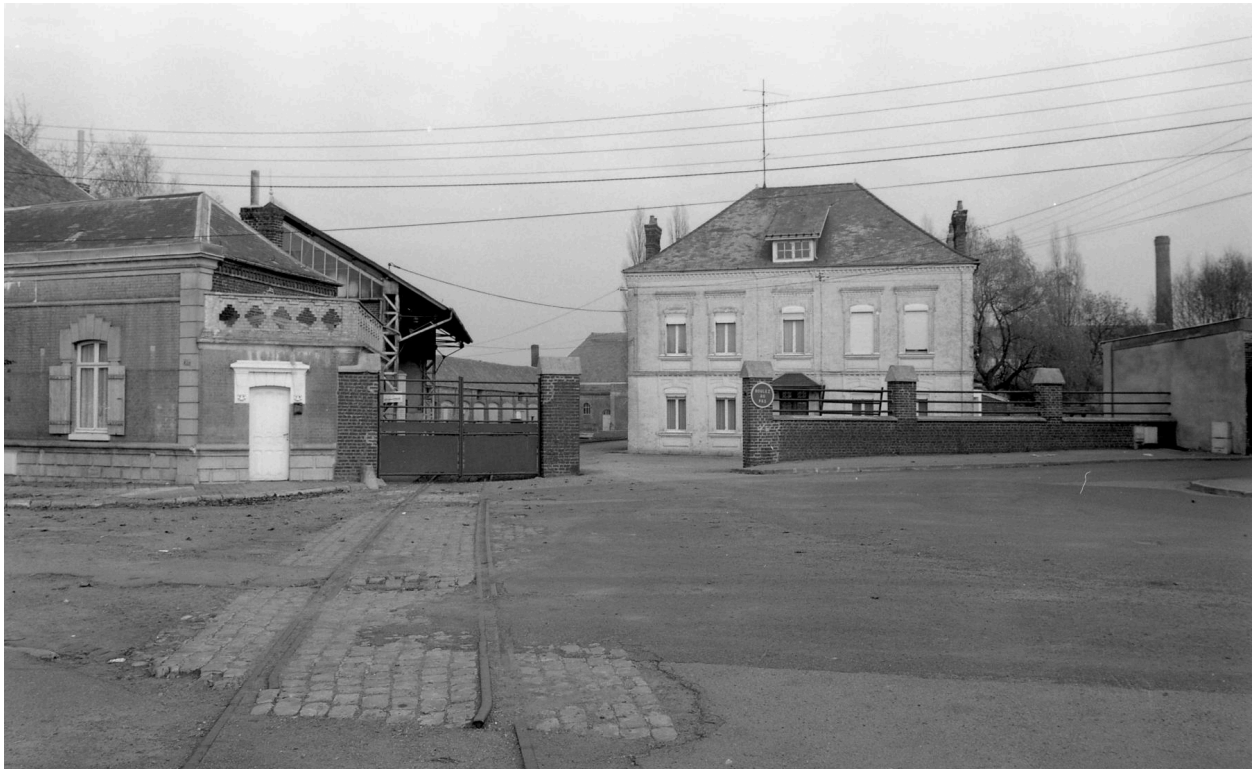
L'entrée principale de la verrerie et de la façade sud du logement de direction en 1989.
