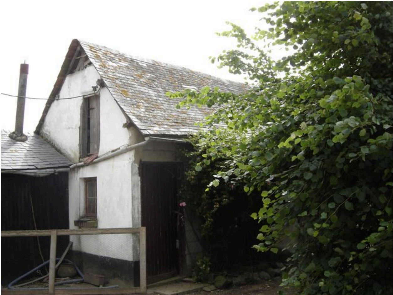
Vue de la laiterie.
