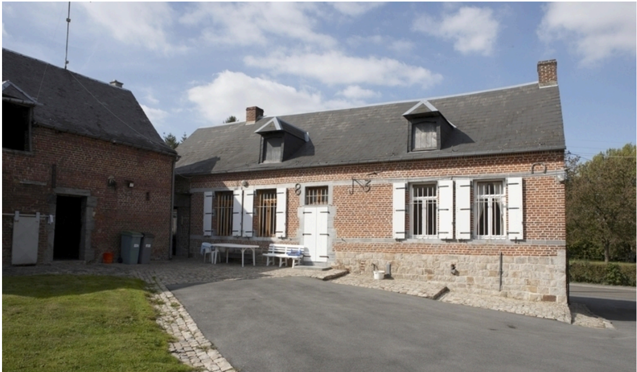
Vue du logis et vue partielle de l'étable attenante.
