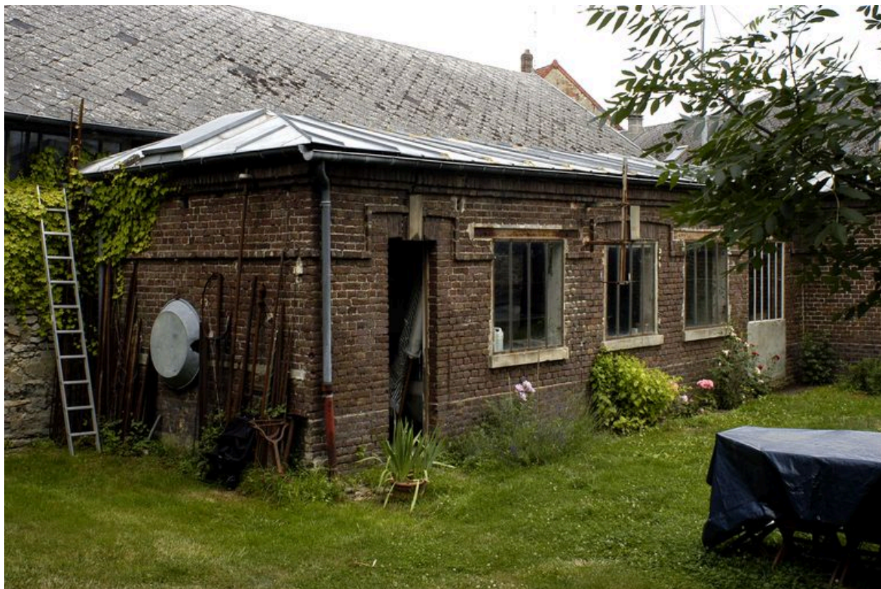
Remise à l'entrée de l'usine, vue d'ensemble.
