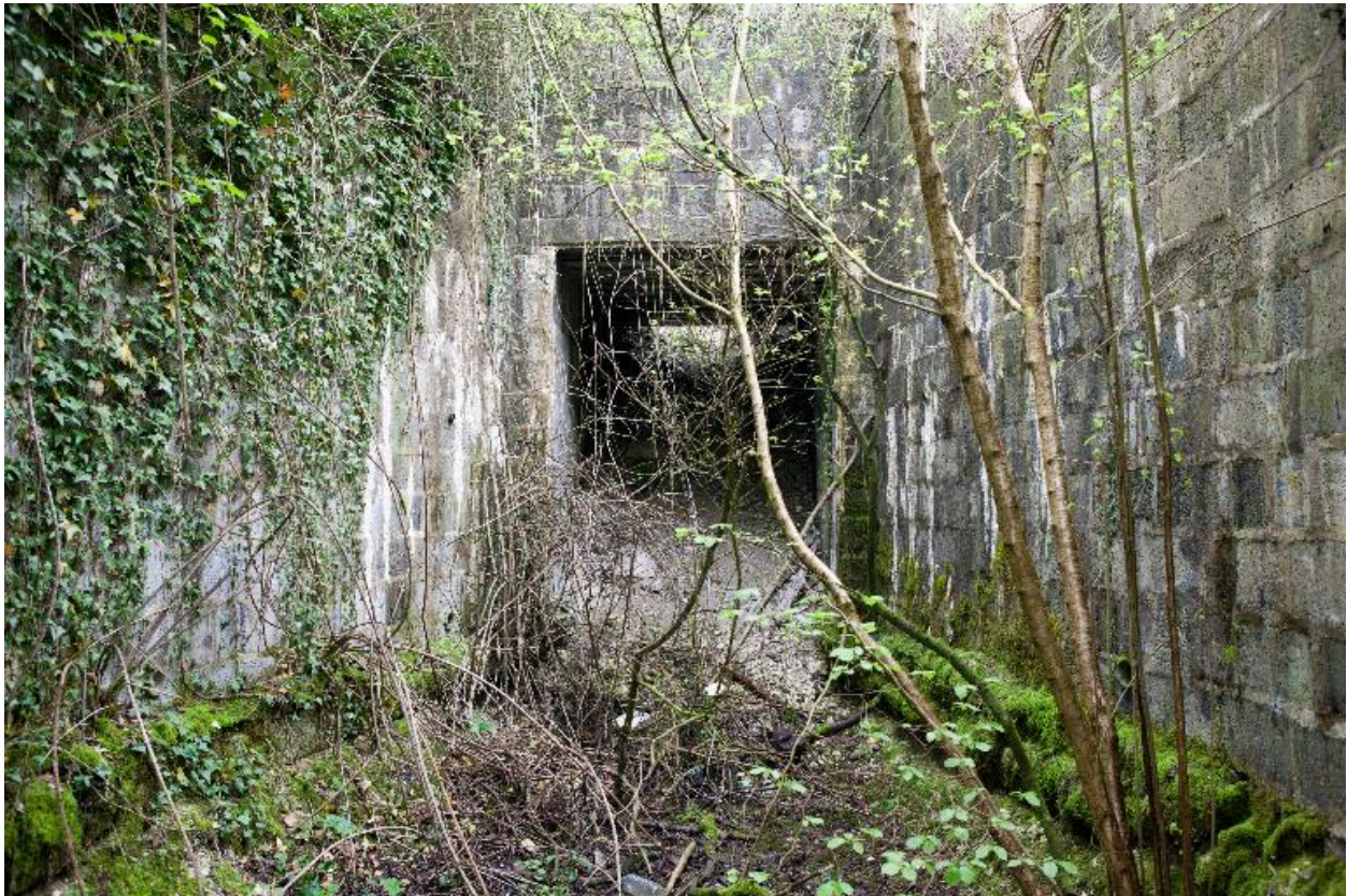
Vue des tunnels. Murs de protection.
