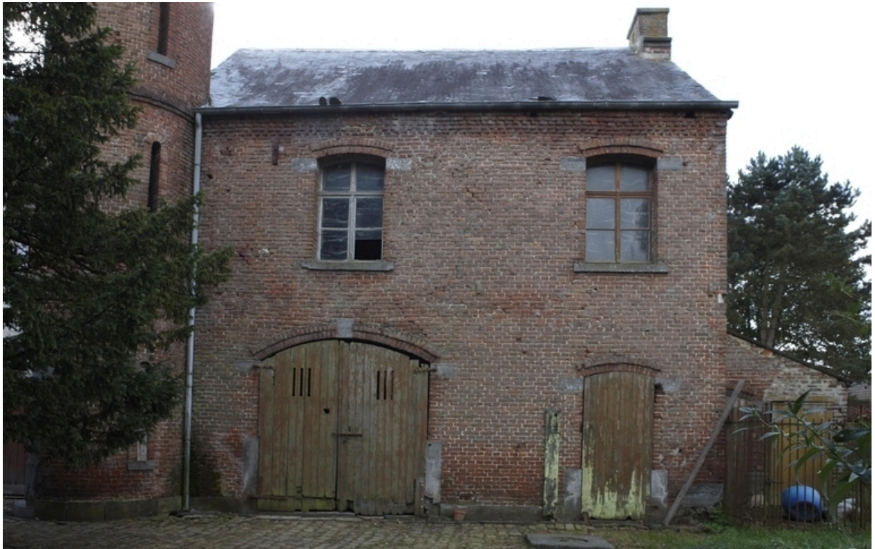
Vue de la façade sur cour des écuries.
