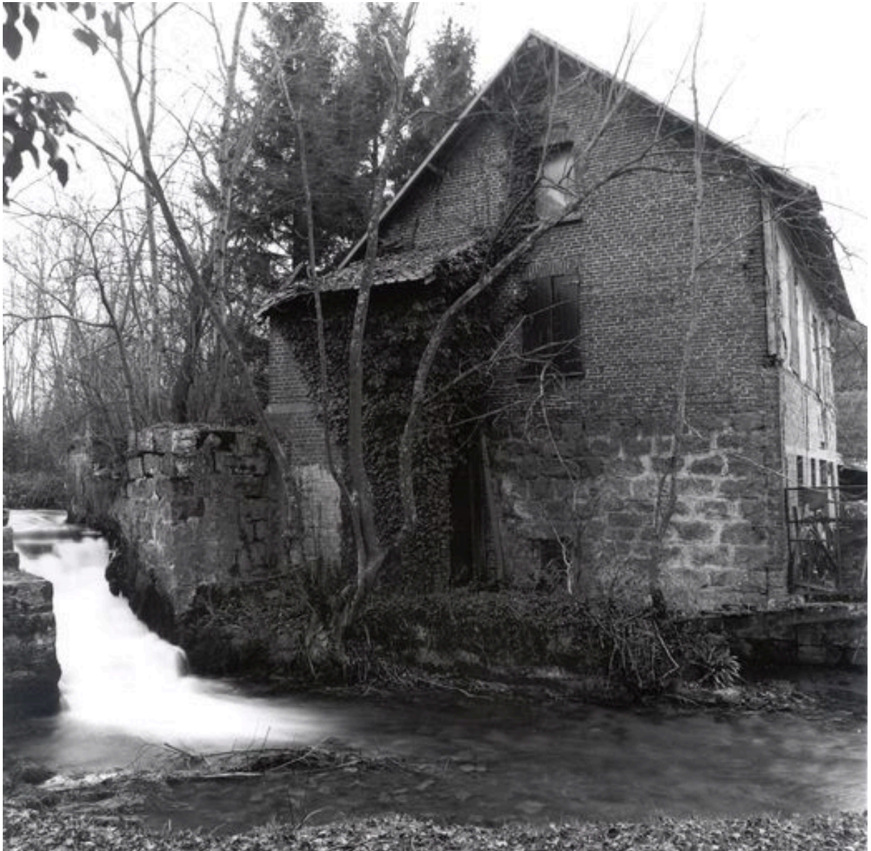
Pignon, la coulerie et le déversoir du moulin.
