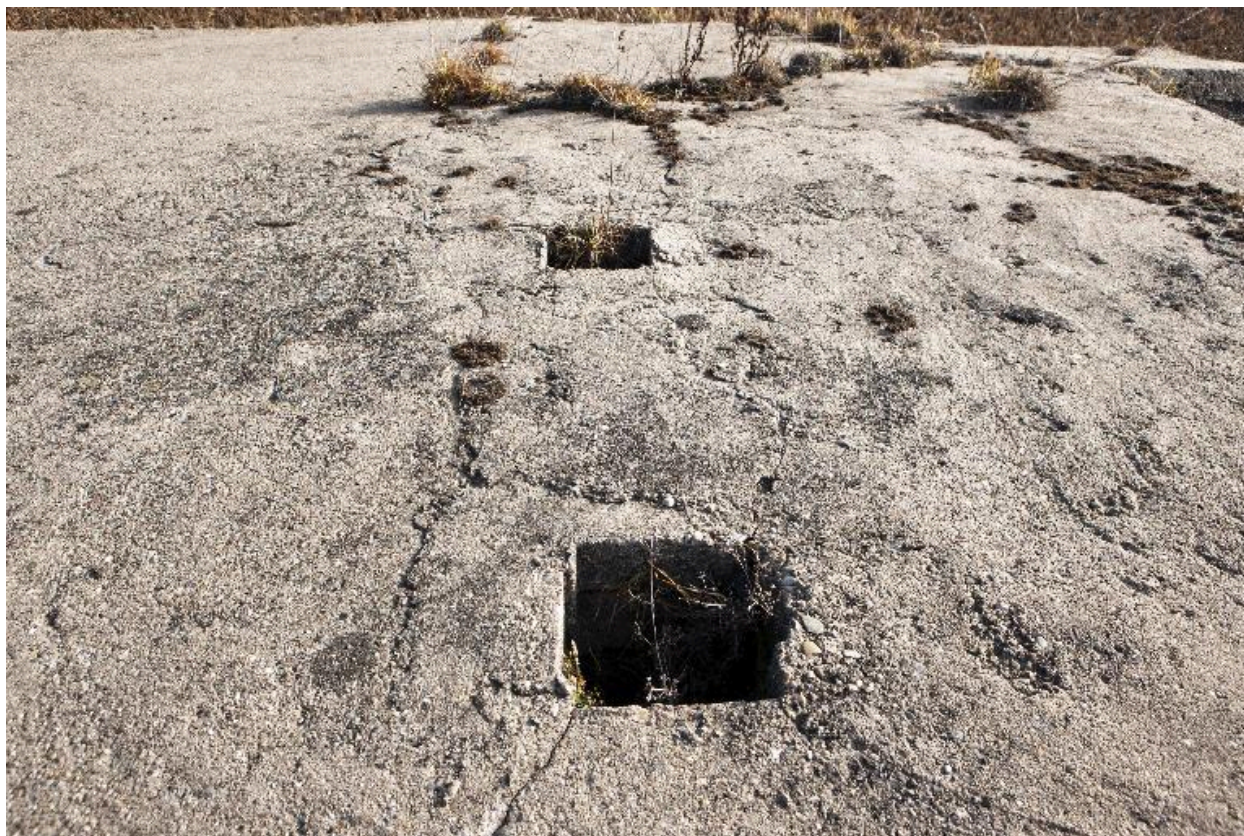
Toit de l'édifice. LEs deux cheminée à périscope
