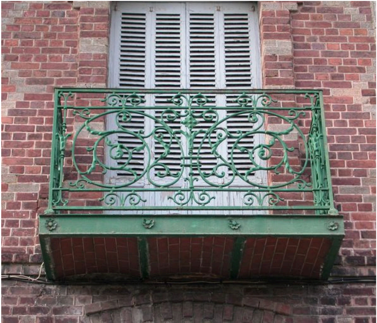
Détail du décor de fonte d'un garde-corps de balcon de l'habitation dite Gypsie.
