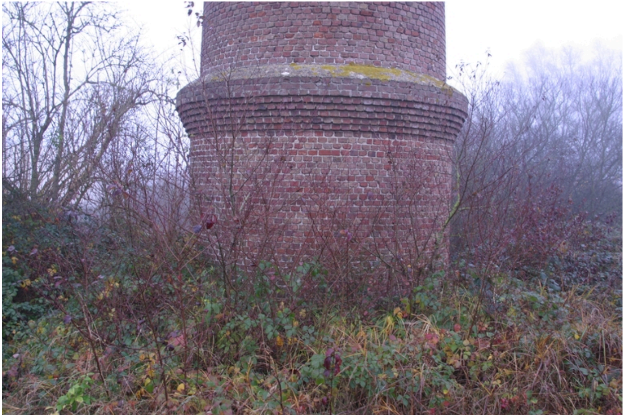
La base de la cheminée.
