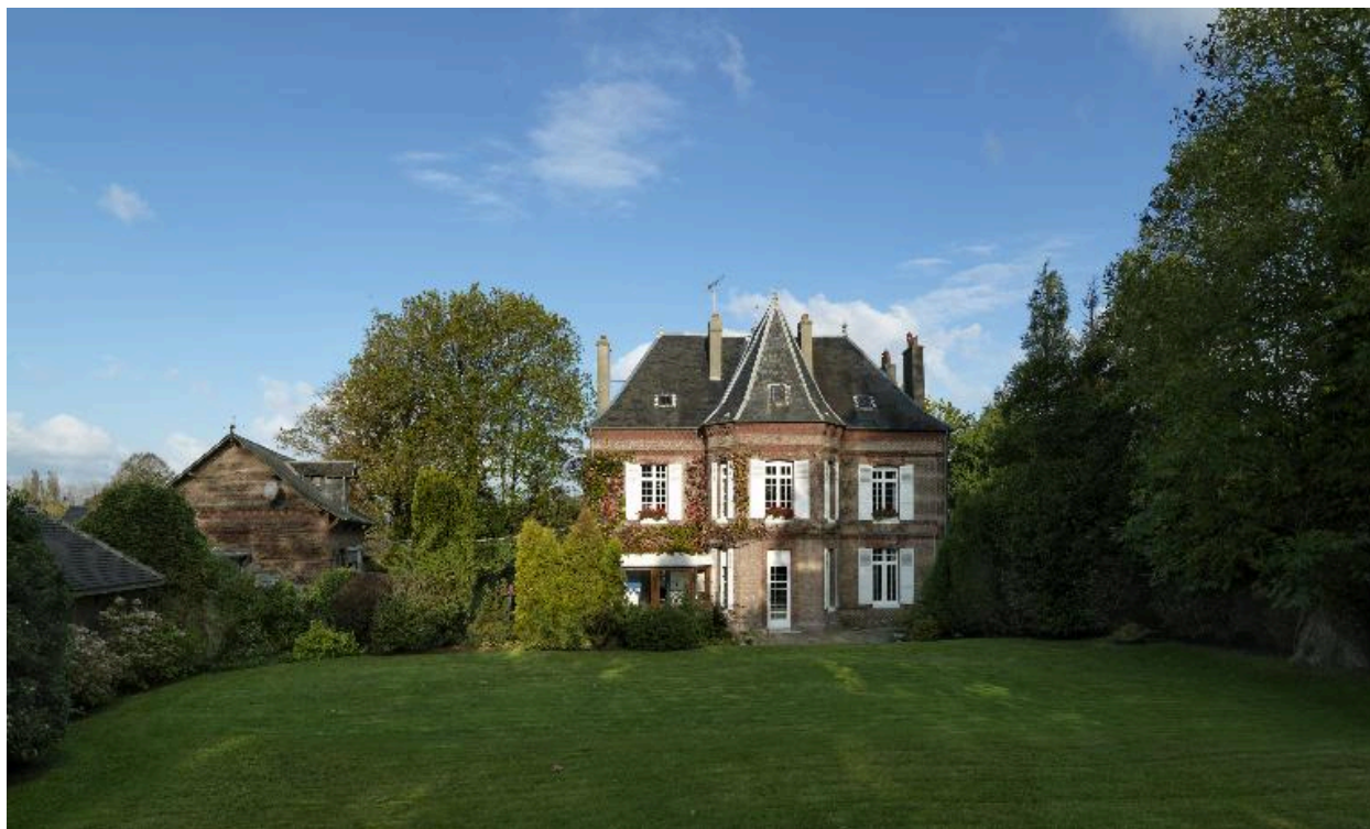
Vue générale de l'arrière de la propriété.
