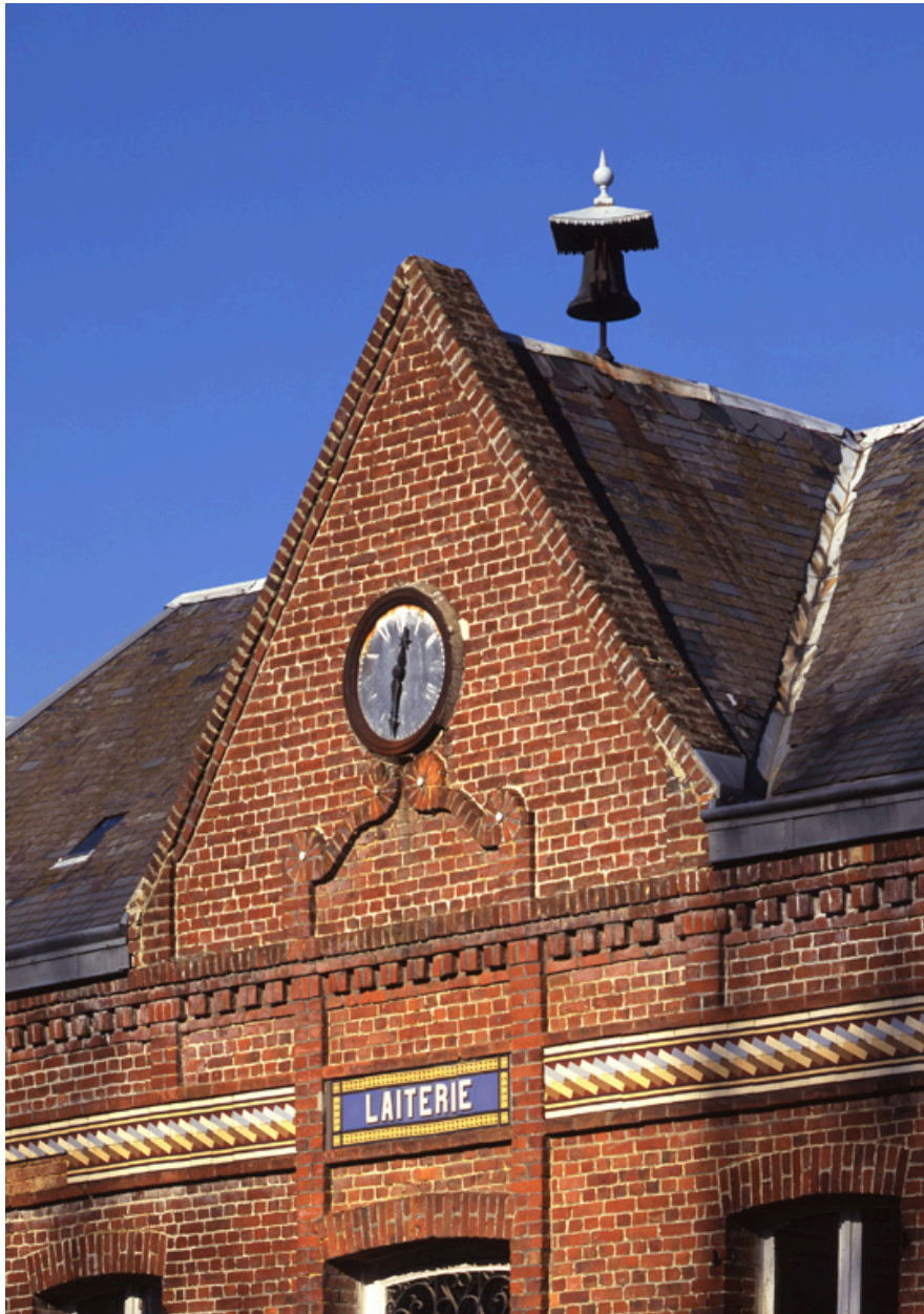
Vue de détail du fronton et de l'horloge.
