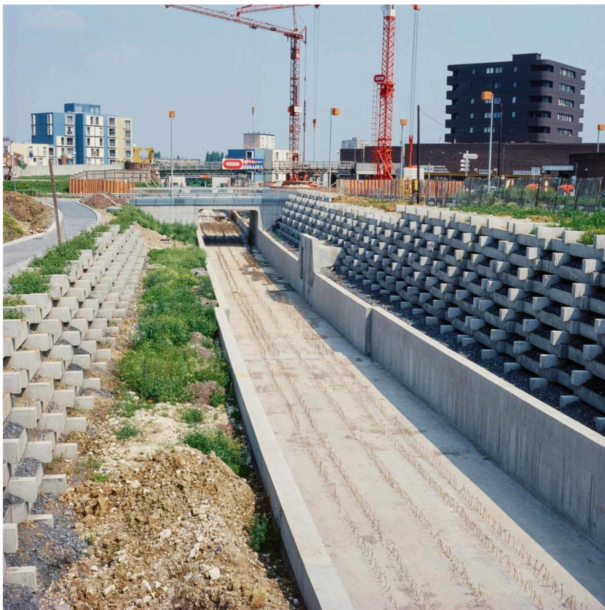
La construction de la ligne de métro au Triolo, en tranchée ouverte, fin 1979 (AD Nord ; fonds CETE, 101Fi3071).
