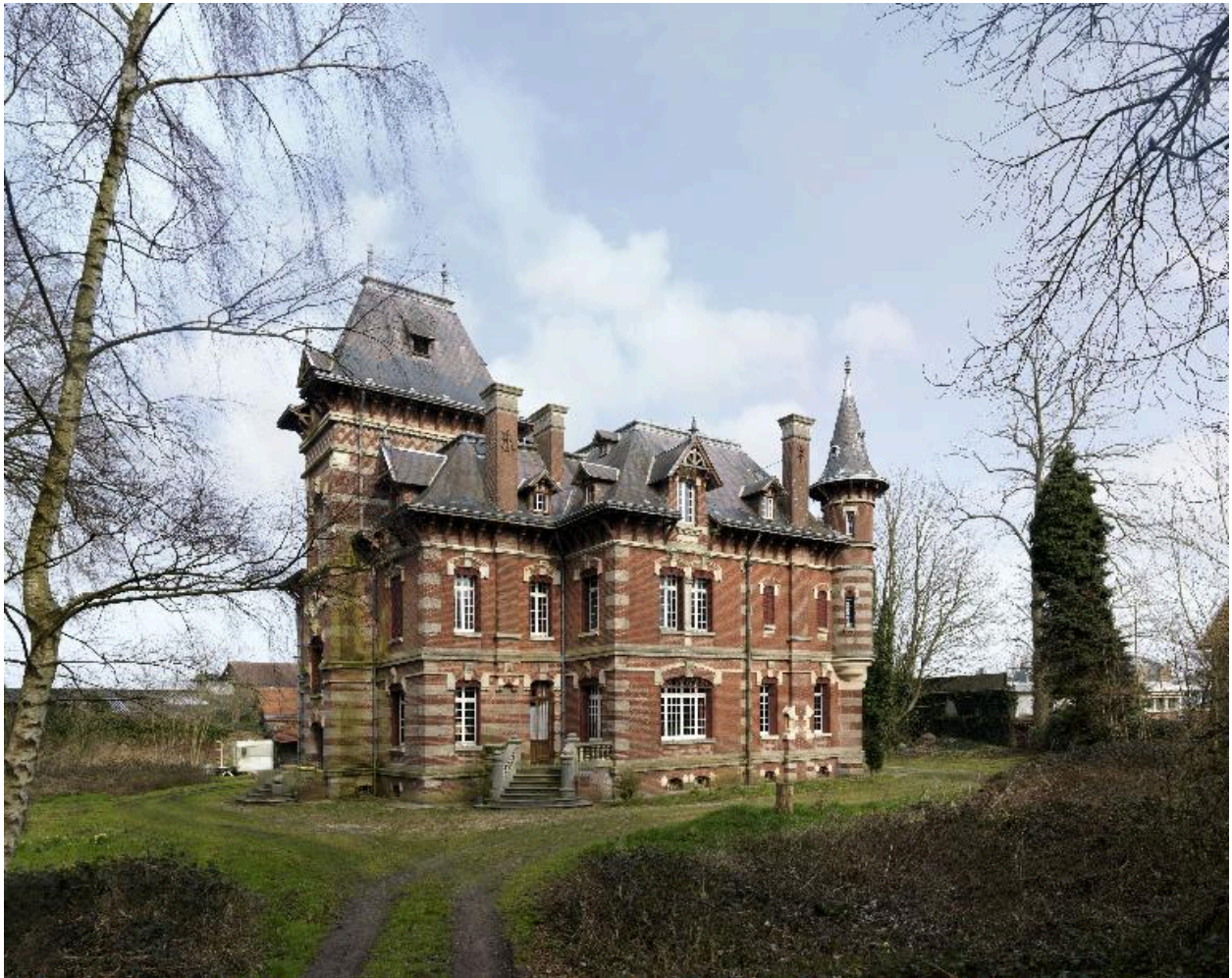
Vue de la façade occidentale.
