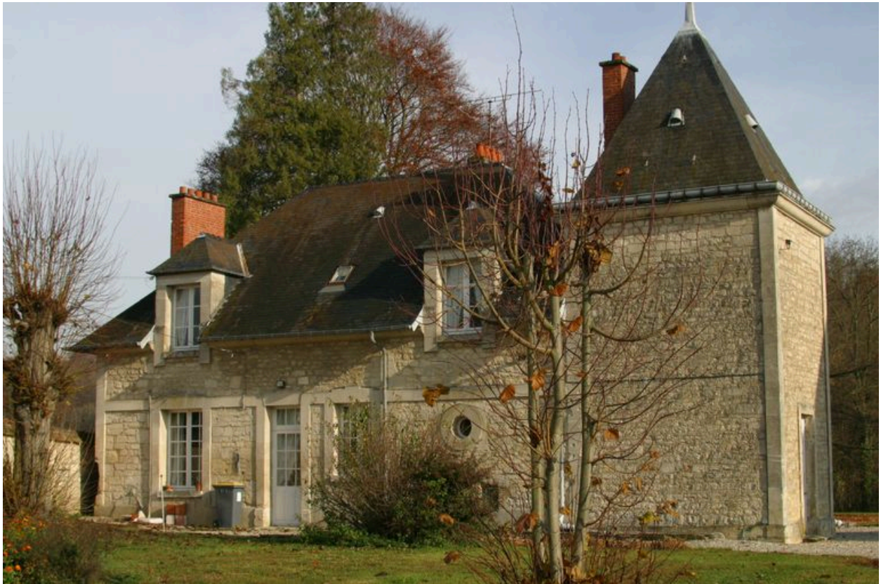
Vue du bâtiment en retour d'angle.
