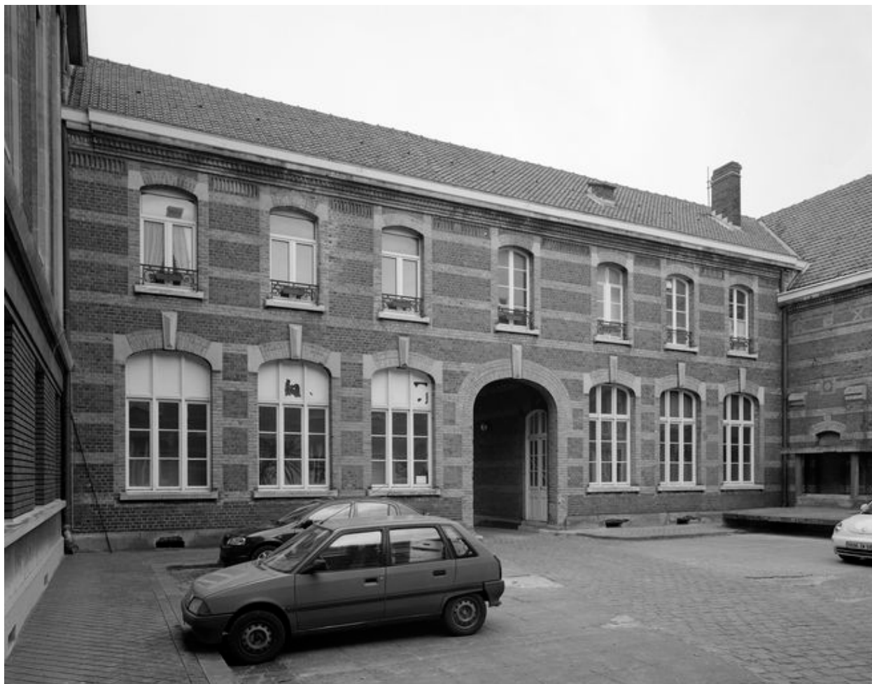
Bâtiment regroupant l'administration, les réfectoires et les services généraux, cour intérieure ouest, élévation du bâtiment fermant la cour du côté ouest, vue générale.
