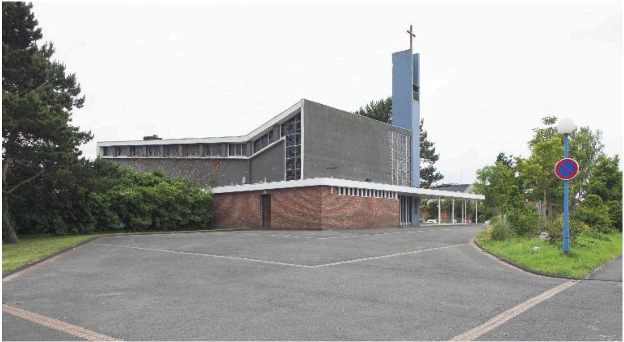
Vue de trois quart de l'élévation antérieure et du flanc gauche.
