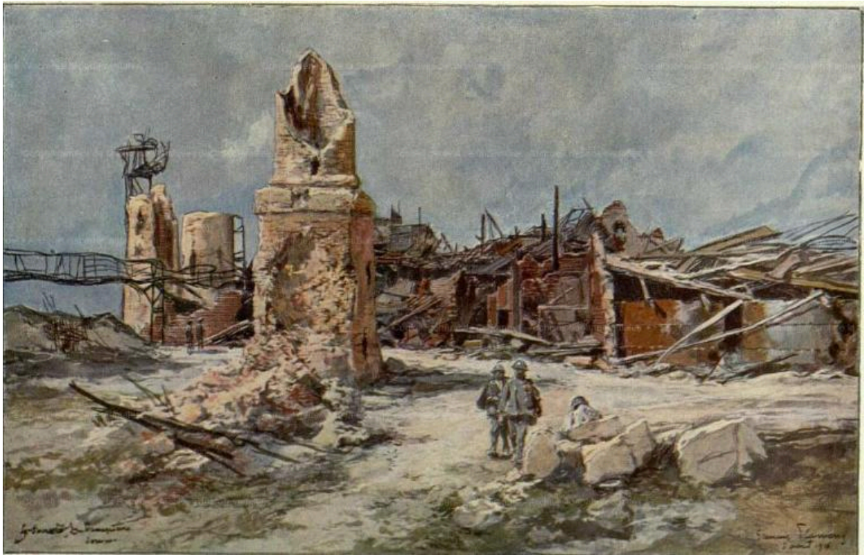
Ruines de la sucrierie de Dompierre, dessiné par François Flameng, août 1916 (L'illustration, août 1916).
