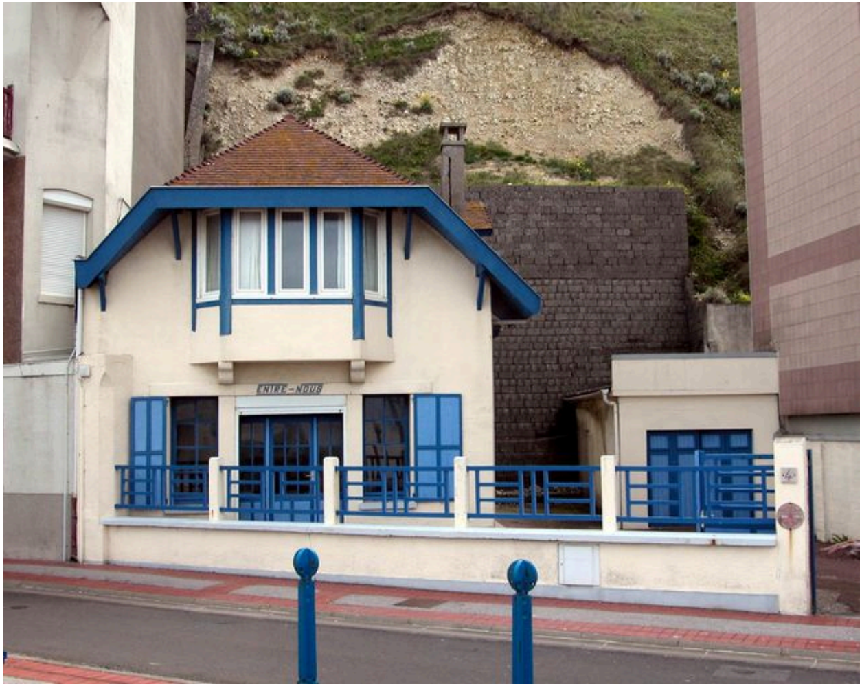
Vue de la maison dite Entre nous, anciens communs de la Villa Barni, rénovés.
