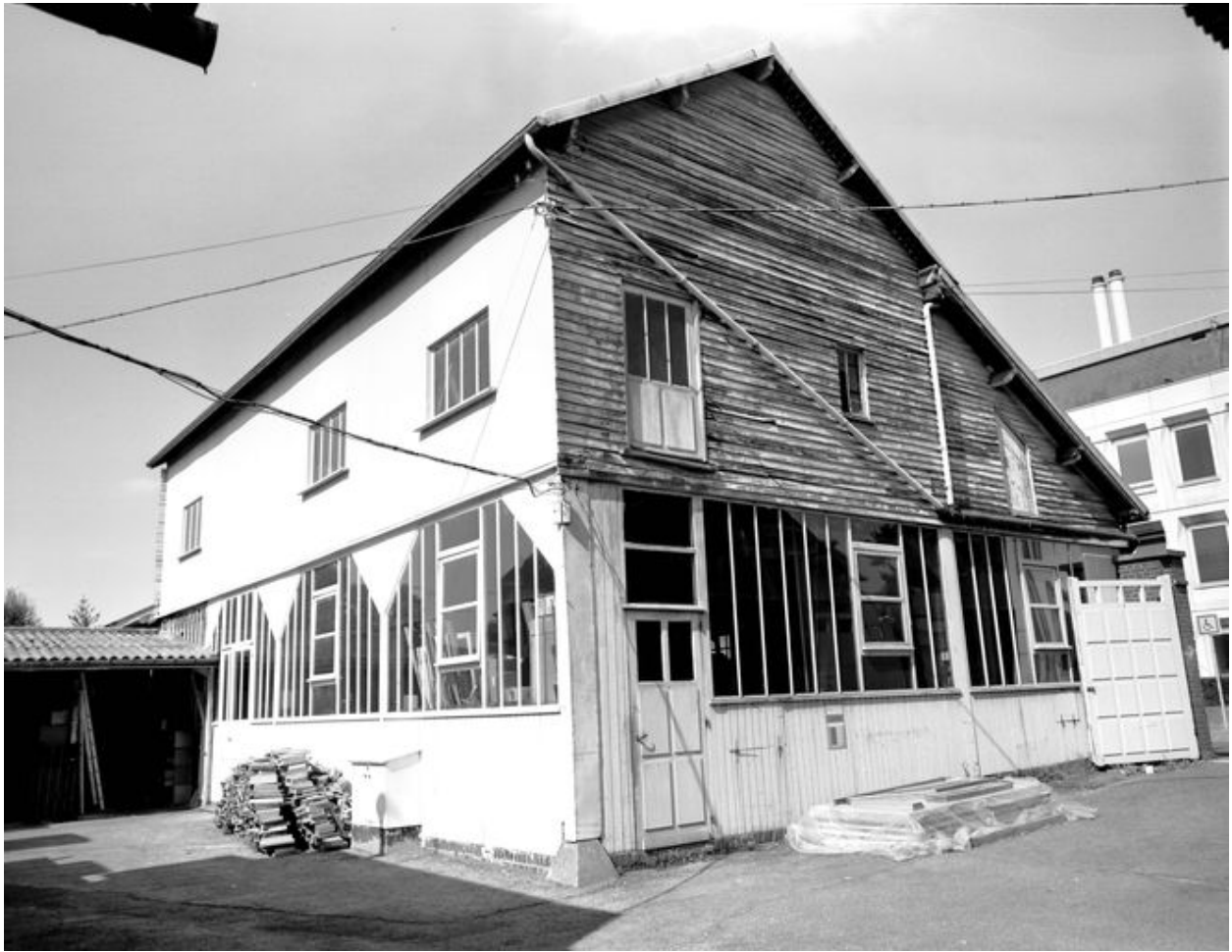
L'atelier de fabrication, pignon sud-est.
