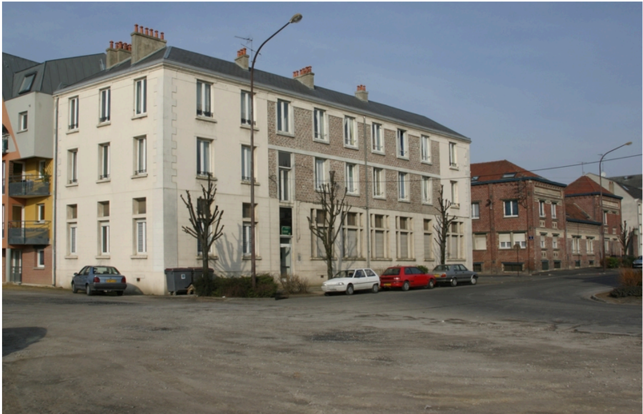
Façade antérieure de l'ancien tissage, vue depuis le quai Gayant.
