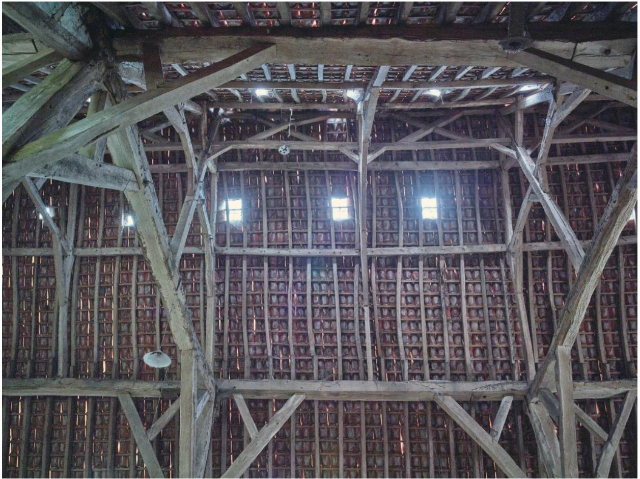
Fermes des Berceaux : grange monastique : détail du contreventement et des fermes.
