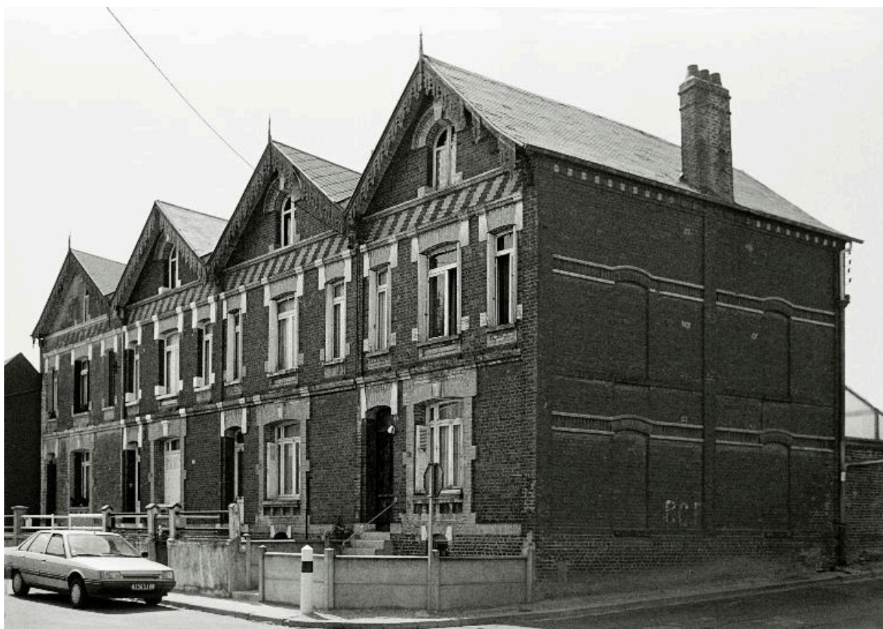
Vue de trois-quarts depuis la rue du Bas, en 1990.
