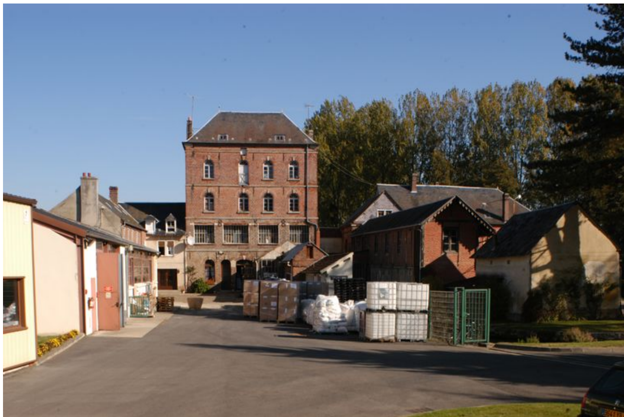
Vue d'ensemble de la minoterie.
