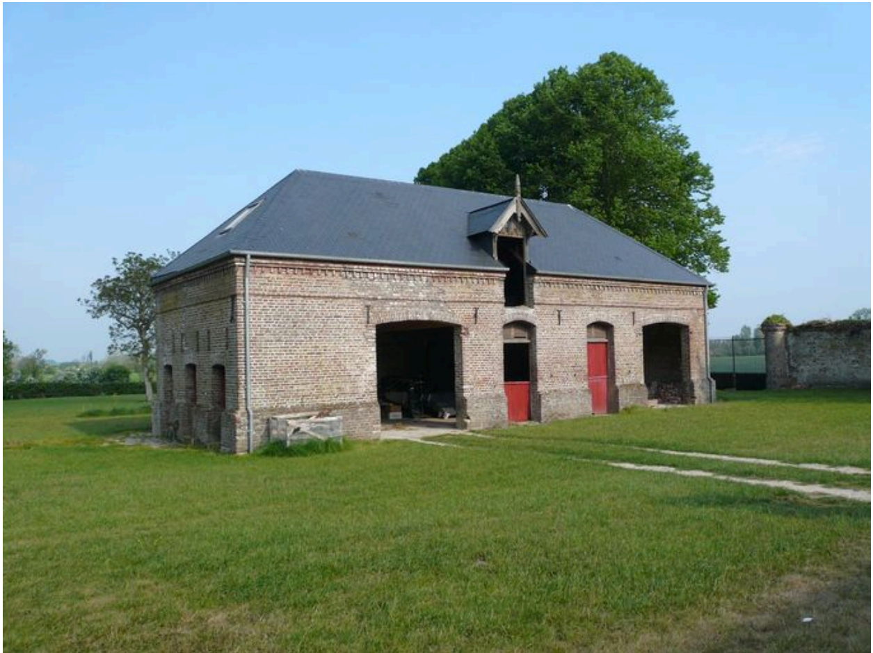
Vue de la grange.
