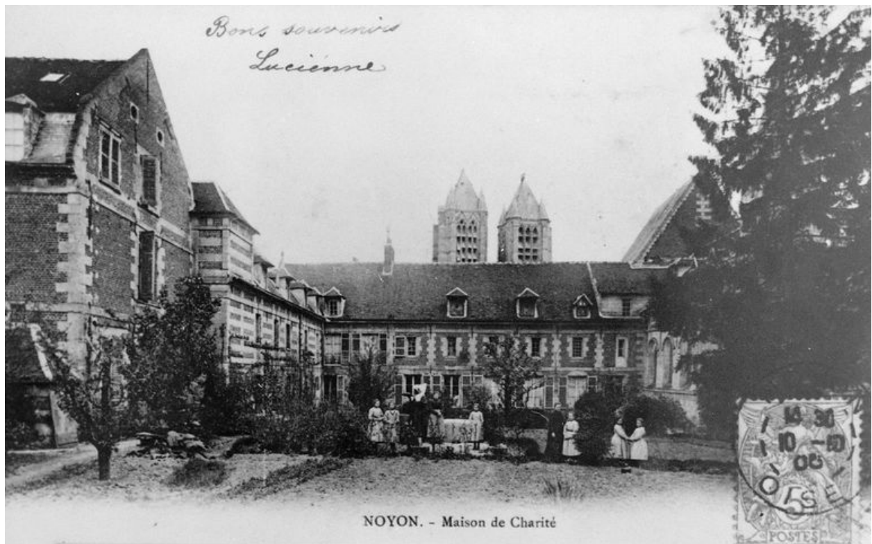
Vue générale d'ouest en est. Avant 1914 (AP).
