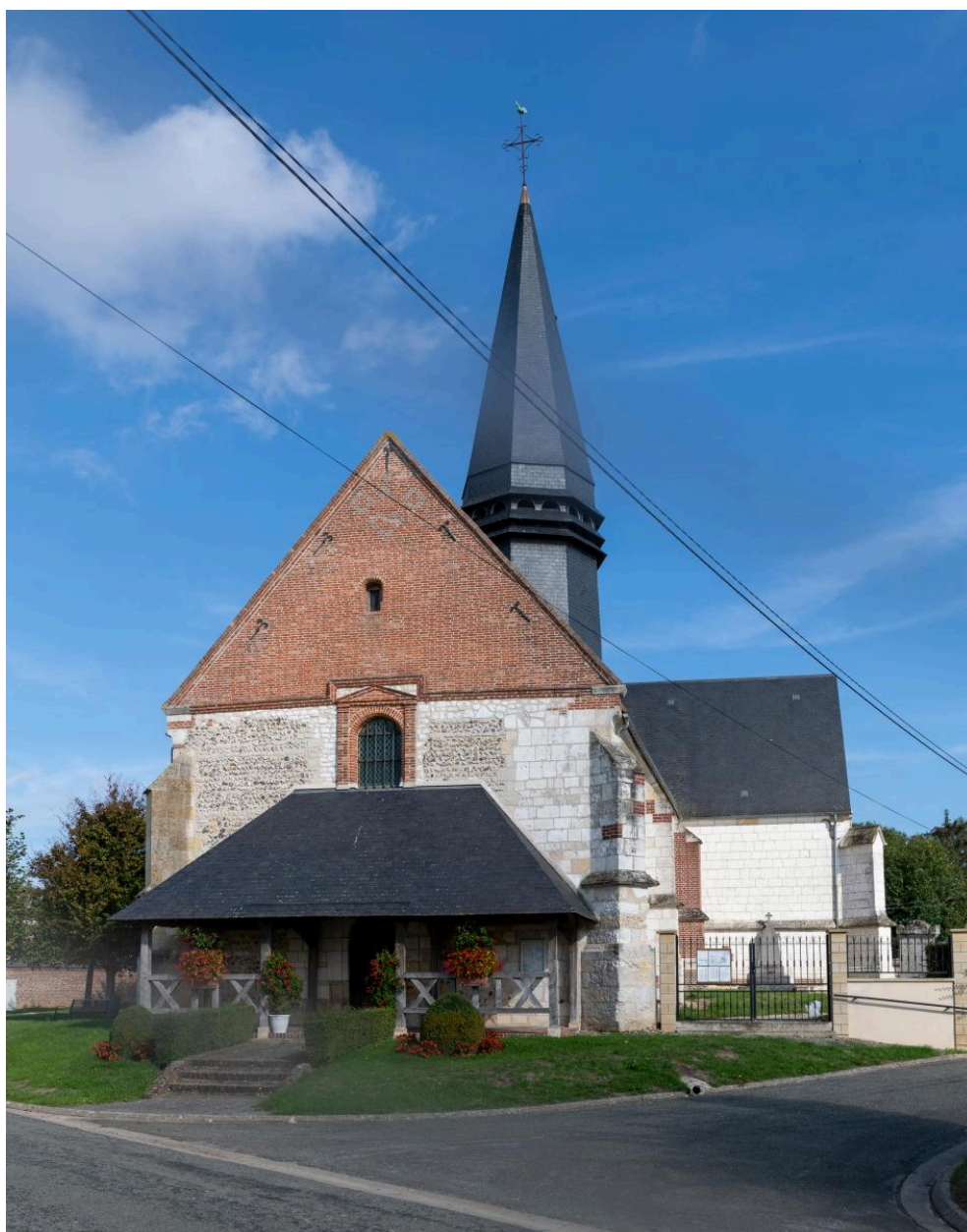
Vue de la façade occidentale.
