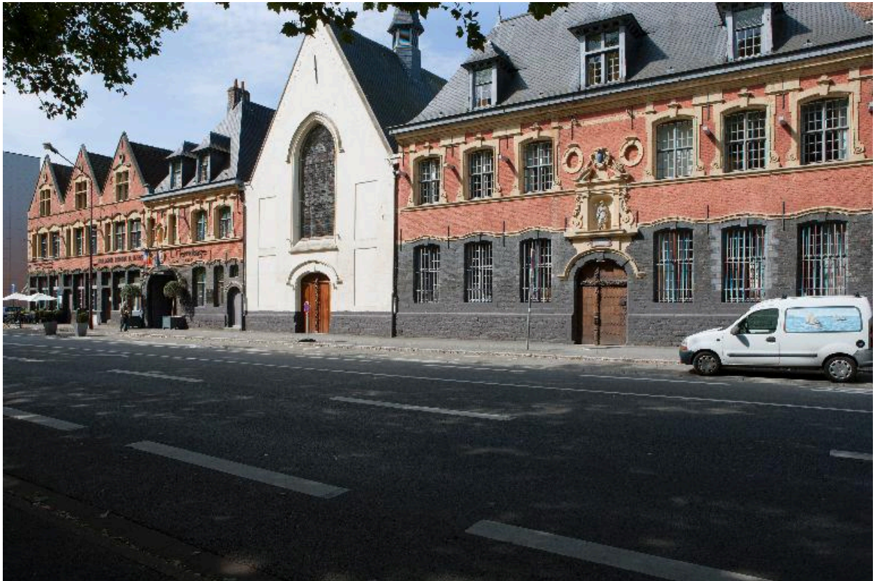
Façade principale donnant sur la rue de Paris, vue générale prise de trois-quarts droit.
