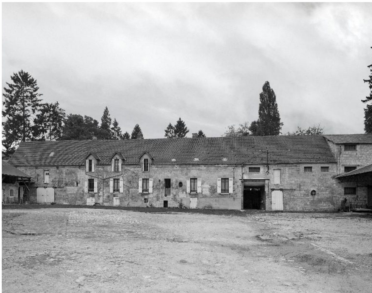
Ferme, rue du Moncet : élévation sur cour des bâtiments ouest.
