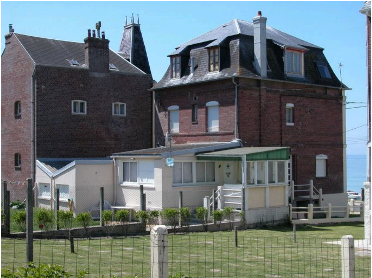
Vue de trois-quarts sur la façade postérieure.
